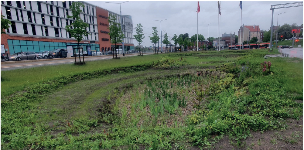
Ogród deszczowy - Gdańsk, ul. 3 Maja. Autor zdjęć: inż. arch. kraj. Eliza Poznańska
