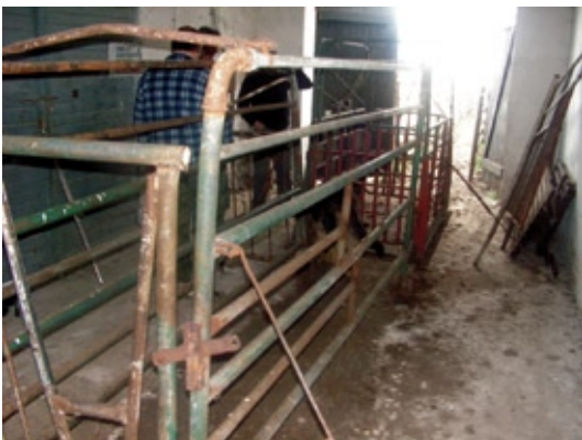
Ażurowe ściany przegród przepędu
